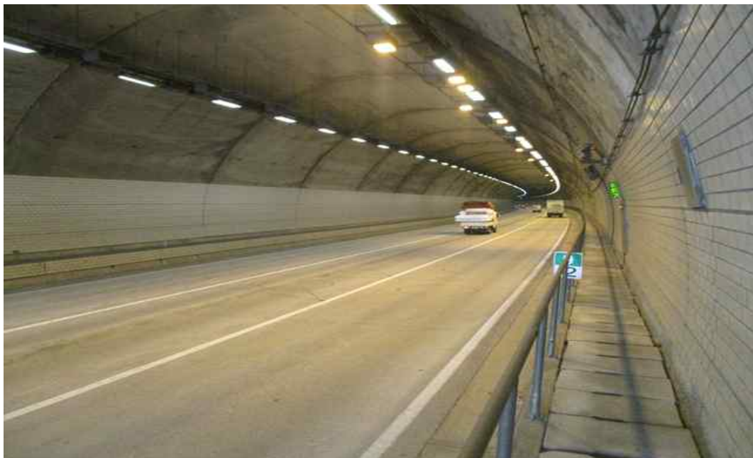
월문1터널(양양) 내부 전경
