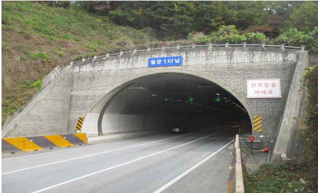
월문1터널(양양) 외부 전경
